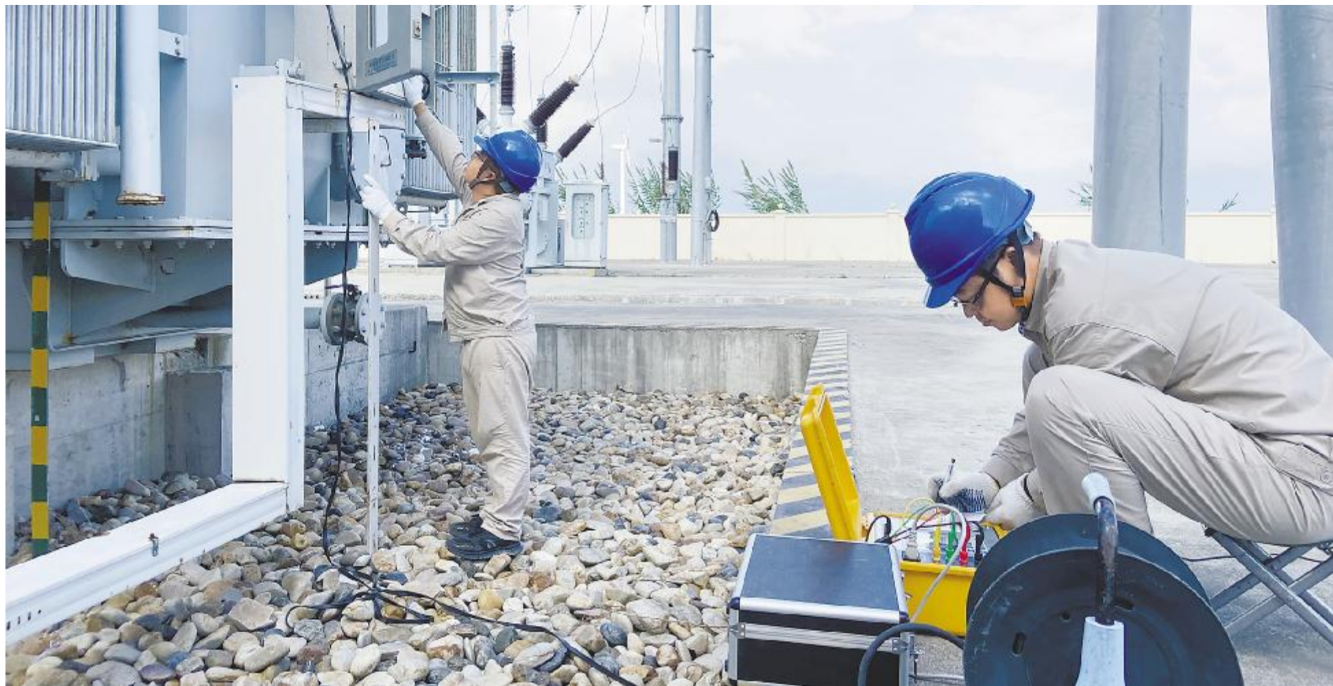
设备维护,护航电站稳定运行
