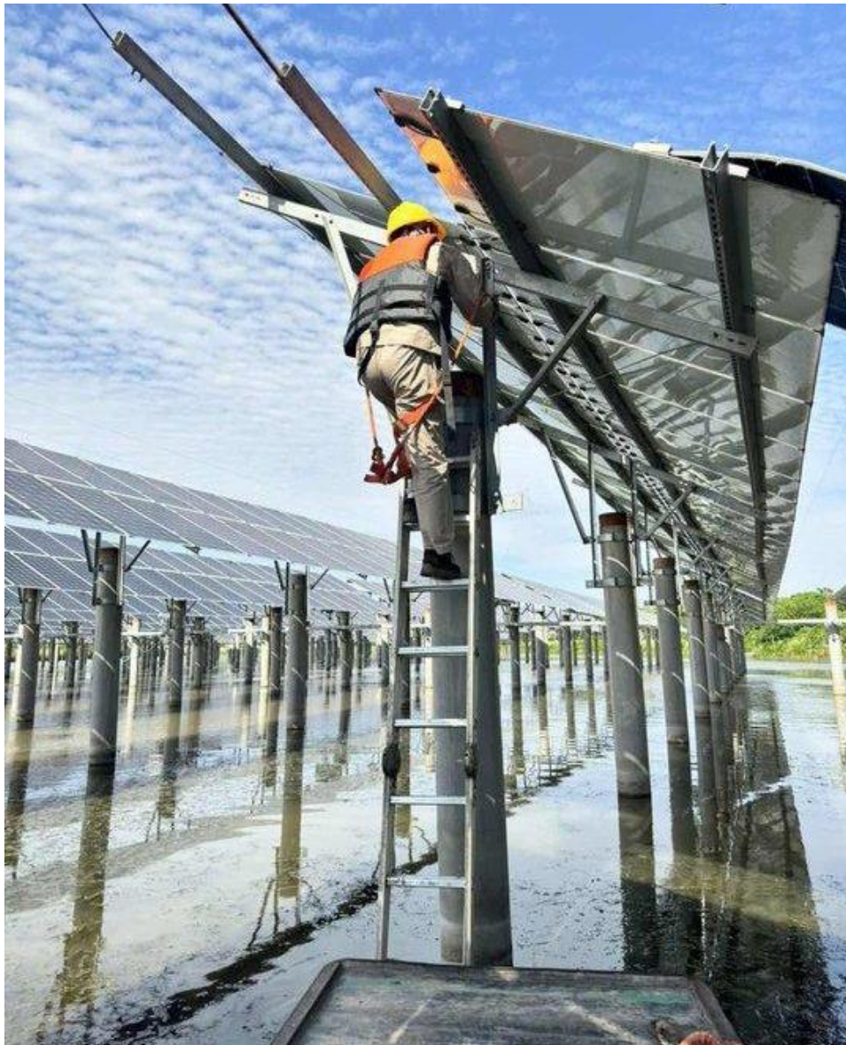
维修光伏组件
