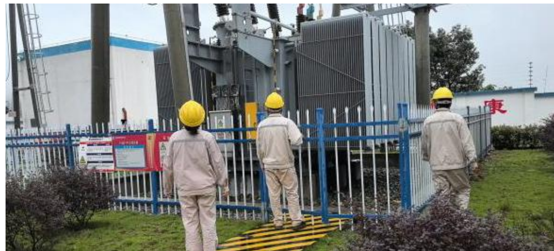
日常巡检,消除隐患
