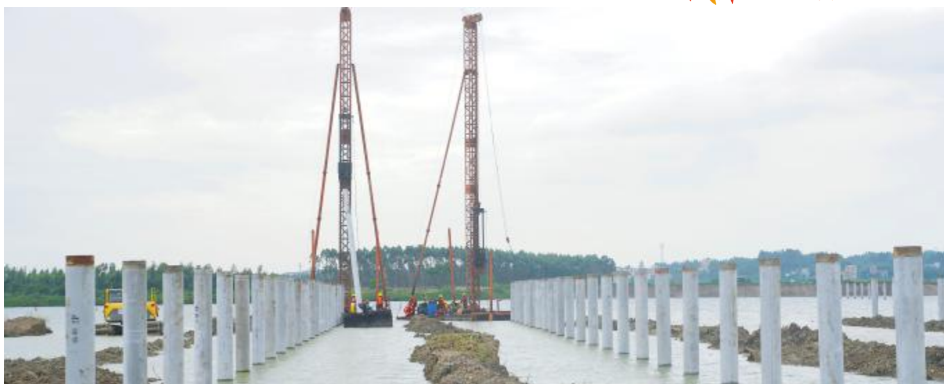
通威麻章“渔光一体”项目开工建设
