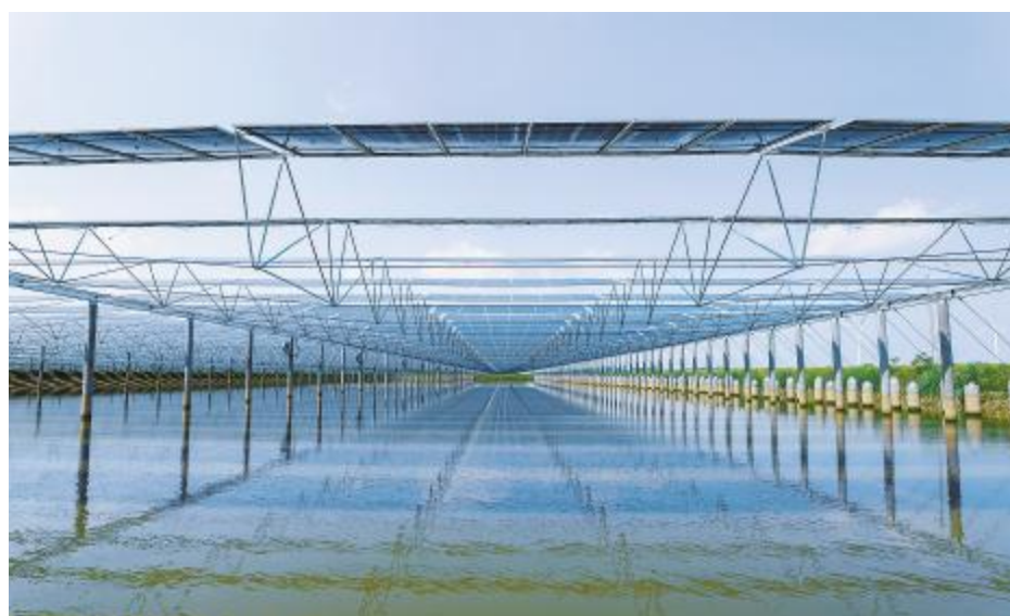
通威天门“渔光一体”基地柔性支架
