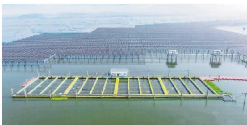
通威泗洪“渔光一体”基地
