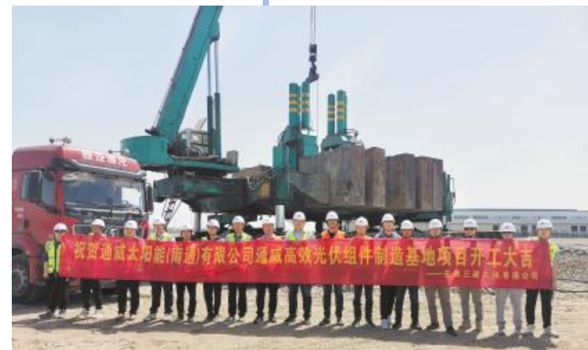
5月8日,通威太阳能(组件)南通基地开工
