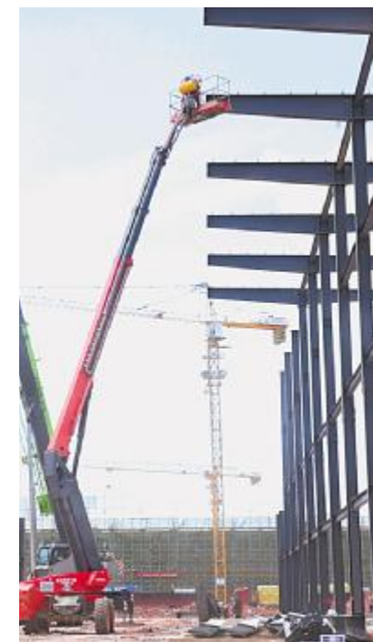
通威太阳能(组件)四川基地建设现场
