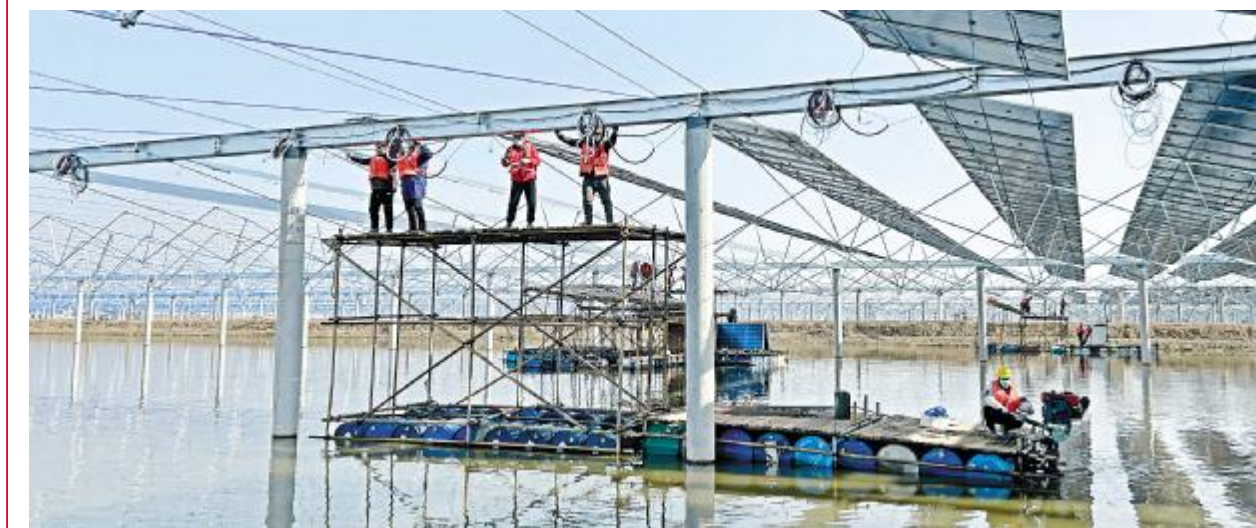
通威天门“渔光一体”二期项目抢抓施工
