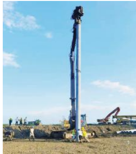
台山项目布下第一根桩
