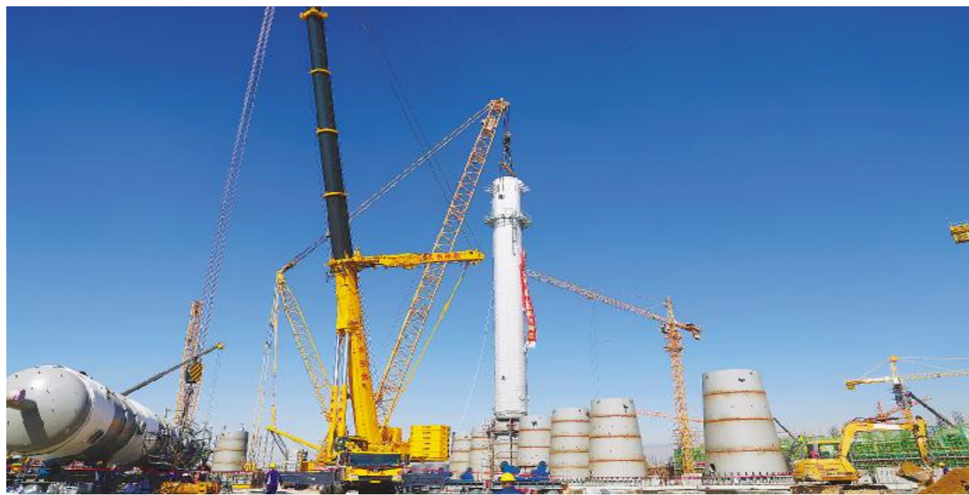
内蒙古通威高纯晶硅公司二期项目精馏装置首吊成功
