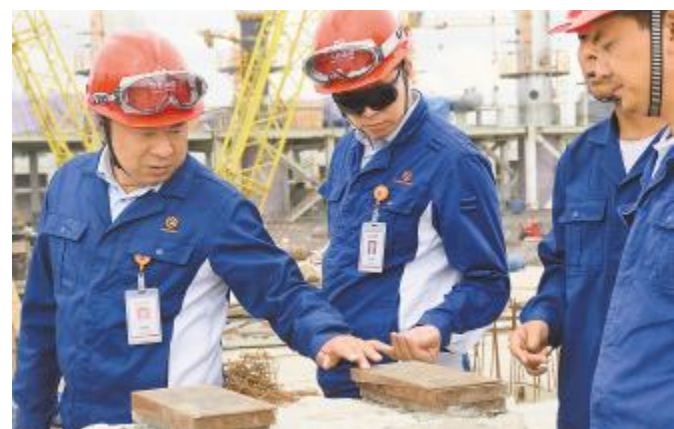
云南通威高纯晶硅公司开展项目现场检查
