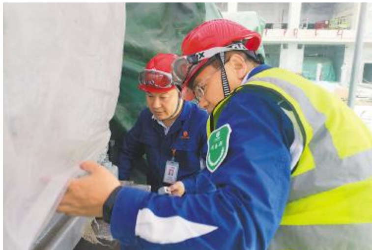
云南通威开展大型设备垫铁安装质量专项检查
