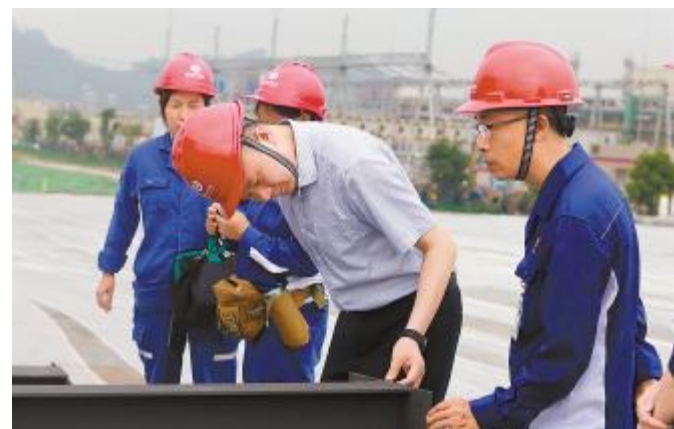
永祥光伏科技开展现场施工情况督察
