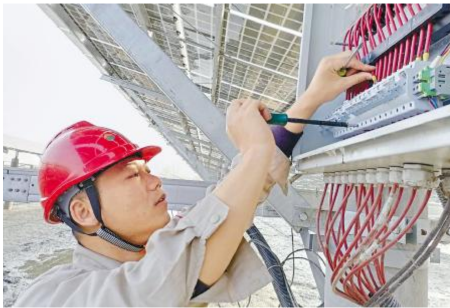
和县电站运维人员开展光伏区巡检
