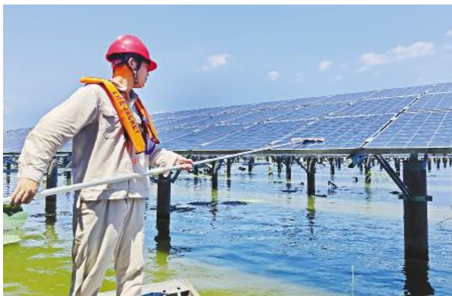
和县电站运维人员定期清理光伏板
