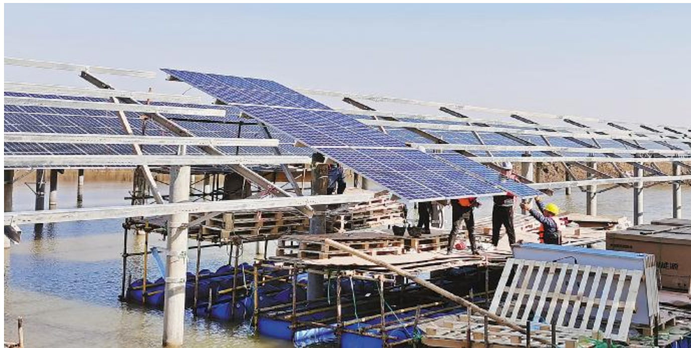
通威东营“渔光一体”生态园项目部冒严寒安装组件
