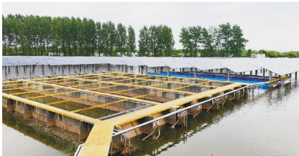
扬中“渔光一体”项目
