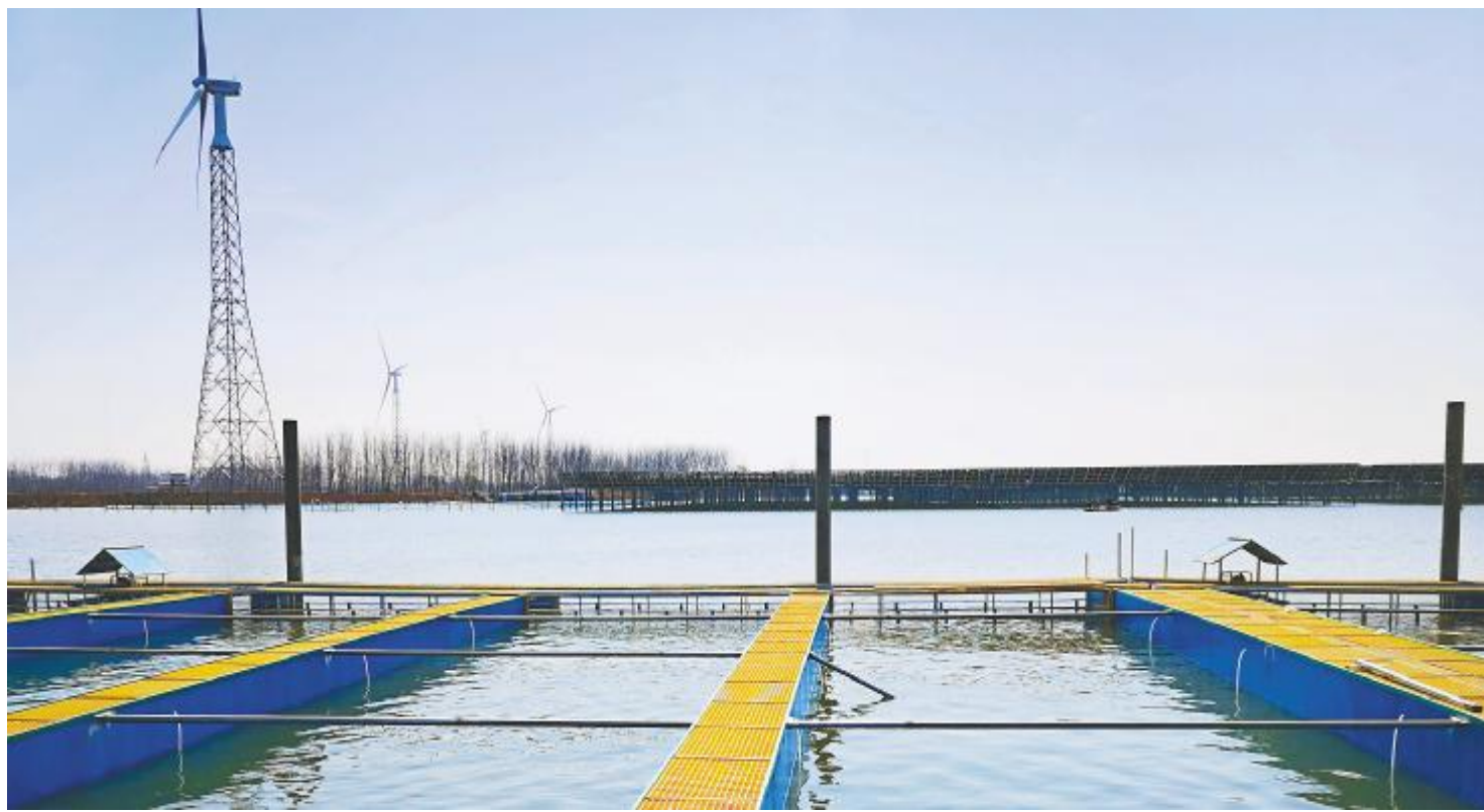
泗洪“渔光一体”项目
