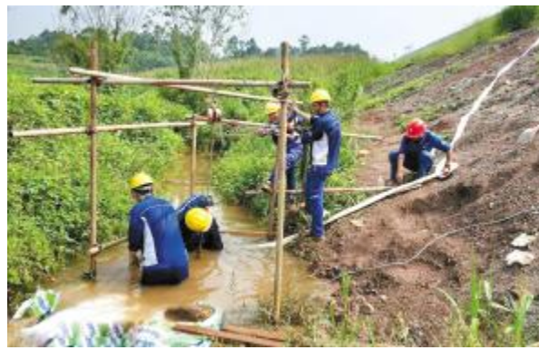
酷暑下,永祥新能源员工进行取水泵安装作业
