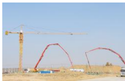
内蒙古通威高纯晶硅项目建设现场
